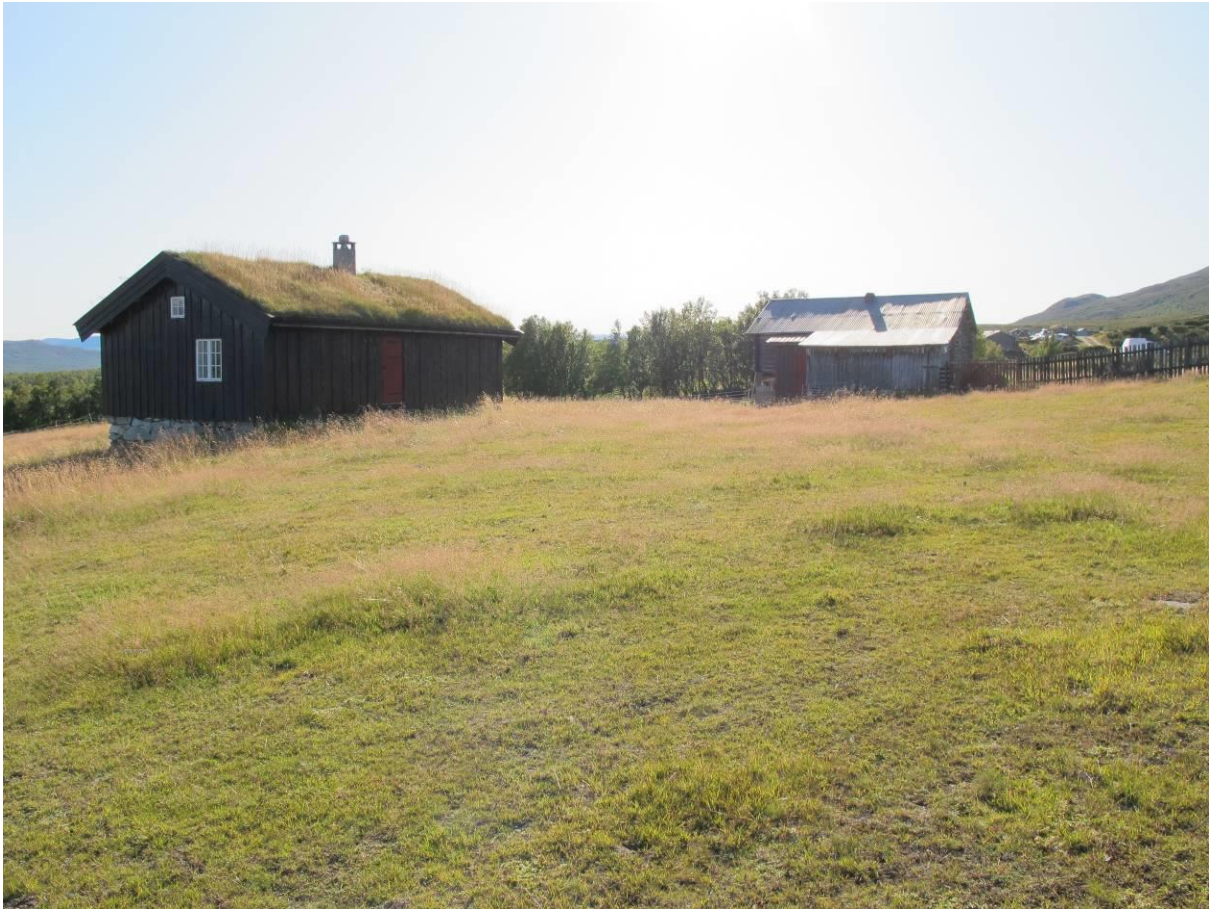
Bilde 3: Bildet viser den delen av kvea hvor det er planlagt å sette opp nytt kokhus.
